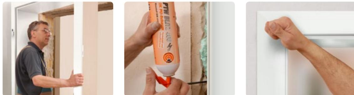
Nach dem Anpassen der Fußleiste an die neue Zargenbekleidung wird die Zarge einfach in die Maueröffnung gestellt, ausgerichtet und mit Türspreizen fixiert. Mit speziellem Montageschaum wird die fachgerechte Montage fortgesetzt. Nach dem Aushärten des Montageschaums wird die Zierbekleidung eingesteckt, das neue Türblatt eingehängt und der Türdrücker aufgeschraubt – fertig!
