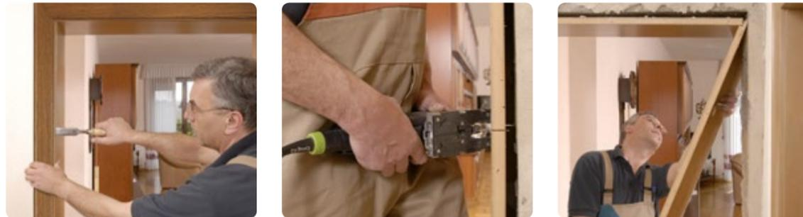
Die Tapete wird um die Bekleidung herum sauber eingeschnitten. Mit einem Stechisen wird die Zierbekleidung von der Zarge gedrückt und das Futterbrett der Zarge im unteren Drittel mit einem sauberen Schnitt durchgesägt. Danach lässt sich die Zarge problemlos ausbauen. Bei der gesamten Demontage fällt kein nennenswerter Schmutz an, da keine Stemmarbeiten oder Ähnliches erforderlich sind.
