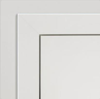
Bei der stumpfen Ausführung bildet das Türblatt eine annähernd bündige Ebene mit der Bekleidung.
